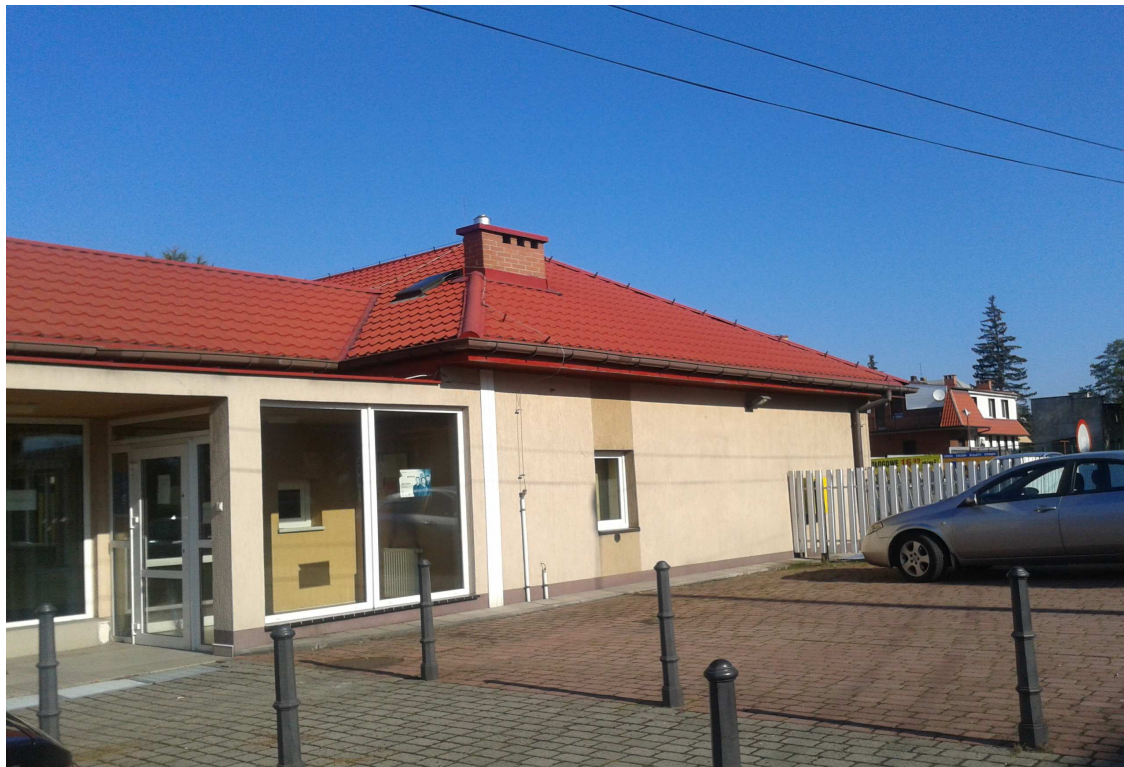
fot1. Elewacja frontowa
