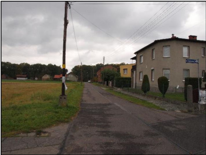
Fot. 2 Ul. K. Dunikowskiego, skrzyżowanie z ul. Rubinową, widok w kierunku południowym
