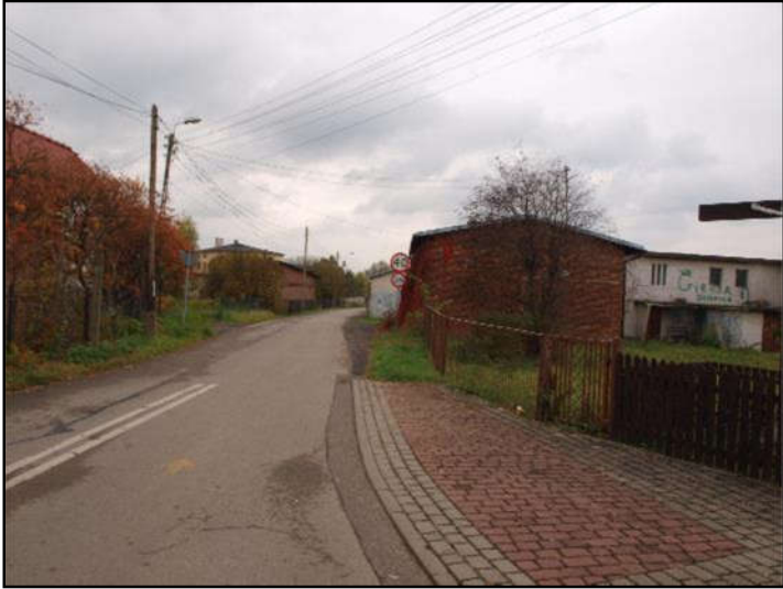
Fot. 13 Zabudowa przy ul. Wandy, północno-zachodnia część obszaru
