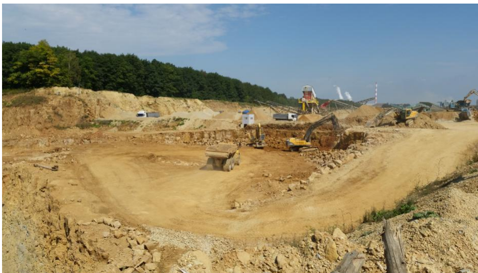
Fot. 6.1. Widok na północne i zachodnie zbocza odkrywki w części południowo - zachodniej złoża „Imielin - Północ” (rejon południowy)
