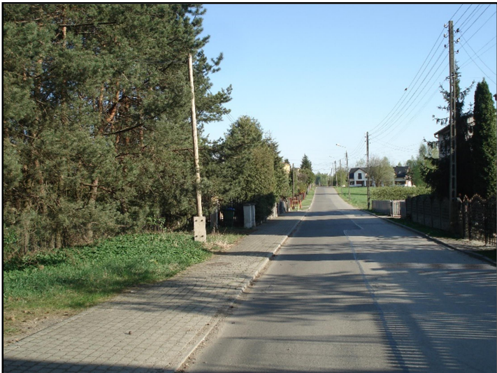
Fot. 14 Ul. Wyzwolenia, zachodnia granica opracowania, widok w kierunku południowym
