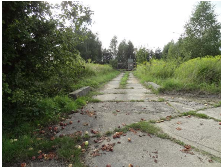
Fot. 3 Teren infrastruktury gazowej w otoczeniu bujnej roślinności
